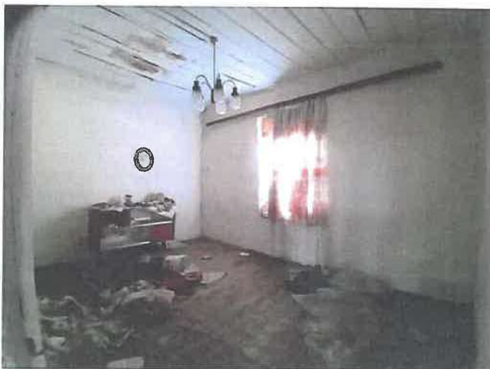
Φωτογραφία 16: Εσωτερικός χώρος Ορόφου (Μάρτιος 2024)
