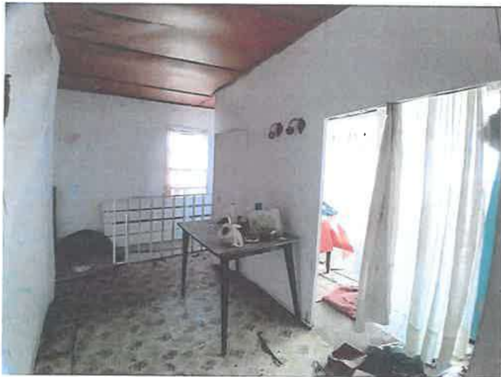
Φωτογραφία 15: Εσωτερικός χώρος Ορόφου (Μάρτιος 2024)
