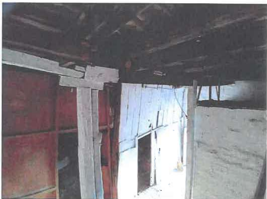
Φωτογραφία 12: Εσωτερικός χώρος Ισογείου (Μάρτιος 2024)
