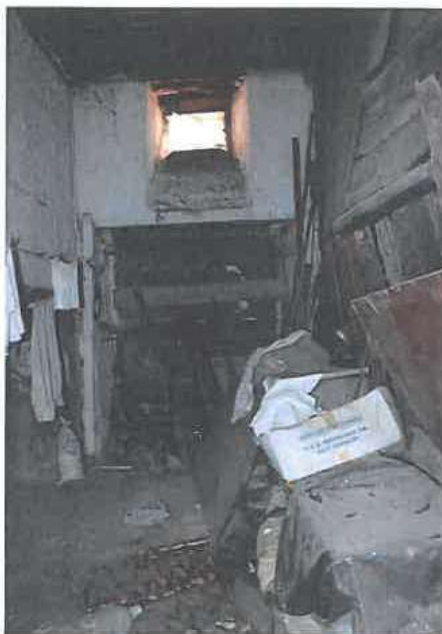
Φωτογραφία 8: Είσοδος από την βορειοδυτική πλευρά του κτηρίου (Μάρτιος 2024)
