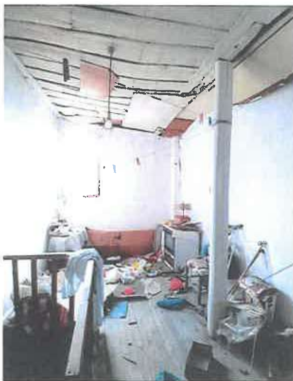
Φωτογραφία 14: Εσωτερικός χώρος Ορόφου (Μάρπος 2024)
