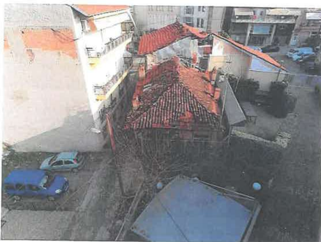
Φωτογραφία 6: Πανοραμικές φωτογραφίες στέγης
