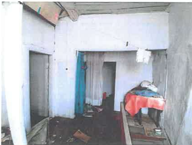
Φωτογραφία 13: Εσωτερικός χώρος Ορόφου (Μάρπος 2024)
