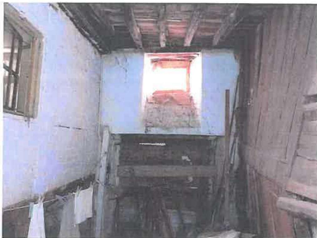
Φωτογραφία 11: Εσωτερικός χώρος Ισογείου (Μάρτιος 2024)
