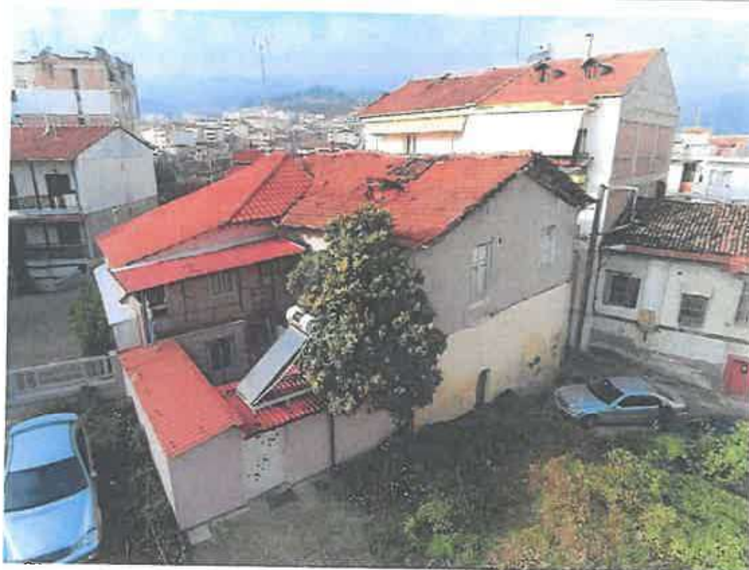
Φωτογραφία 5: Πανοραμικές φωτογραφίες στέγης
