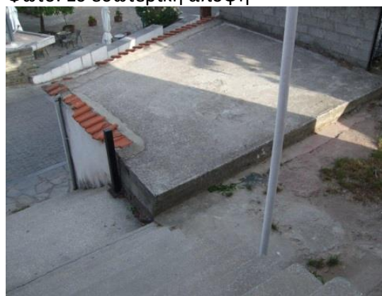
Φωτο. 11 άποψη του δώματος
