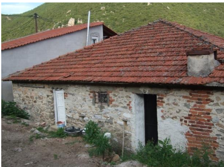
Φωτο. 5 πίσω όψη - μερεμέτι εξωτερικής τοιχοποιίας με τούβλο
