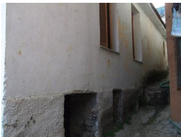
Φωτο. 7 πλαϊνή όψη στο βορρά
