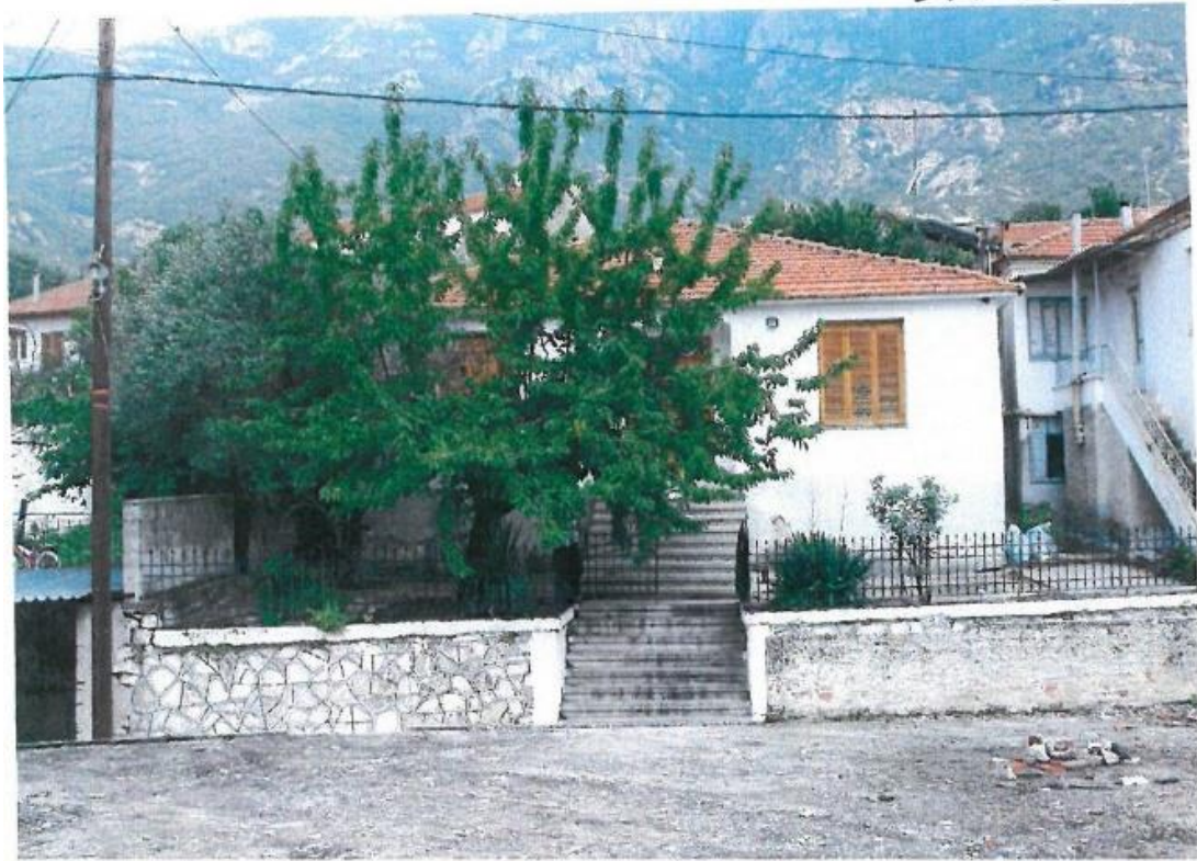
Φωτο. 1 Πρώην Αστυνομικός Σταθμός Μεσορόπης (πριν την κατασκευή των κοιν/στων τουαλετών)
