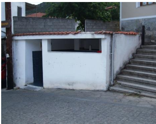
Φωτο. 8 εξωτερική άποψη 1
