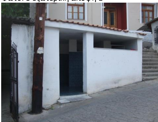
Φωτο. 9 εξωτερική άποψη 2
