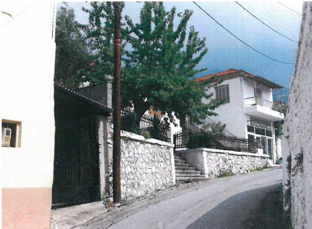
Φωτο. 2 Πρώην Αστυνομικός Σταθμός Μεσορόπης άποψη από τον δρόμο (πριν την κατασκευή των κοιν/στων τουαλετών)
