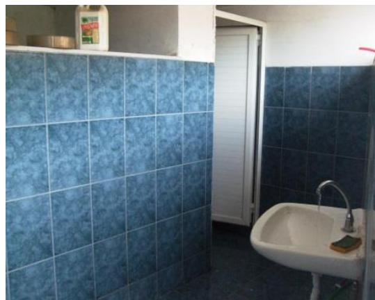
Φωτο. 10 εσωτερική άποψη
