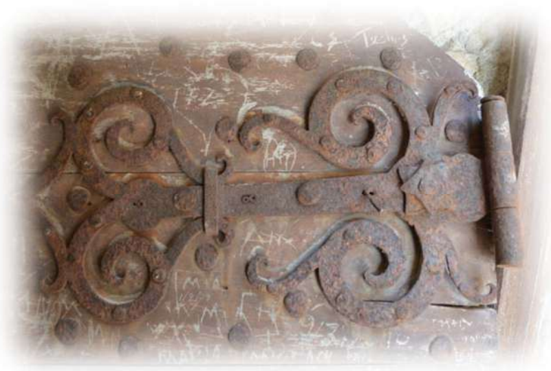
Εικ.18. Λεπτομέρεια σιδερένιου μάσκουλου σε ξύλινη καρφωτή θύρα στον χώρο του εστιατορίου, στα νότια του φρουρίου.
