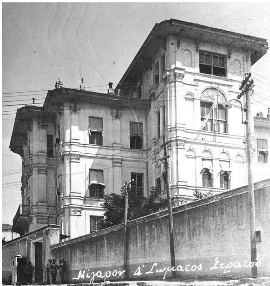
Εικ.1 Όψη του κτηρίου την εποχή που στέγαζε τις υπηρεσίες του Δ' σώματος στρατού
