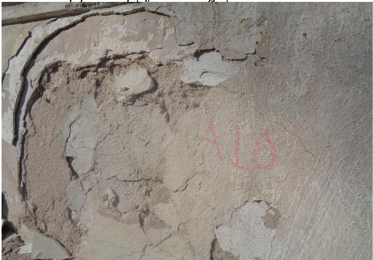
Εικ.49 Επικαλύψεις με νεότερα κονιάματα
