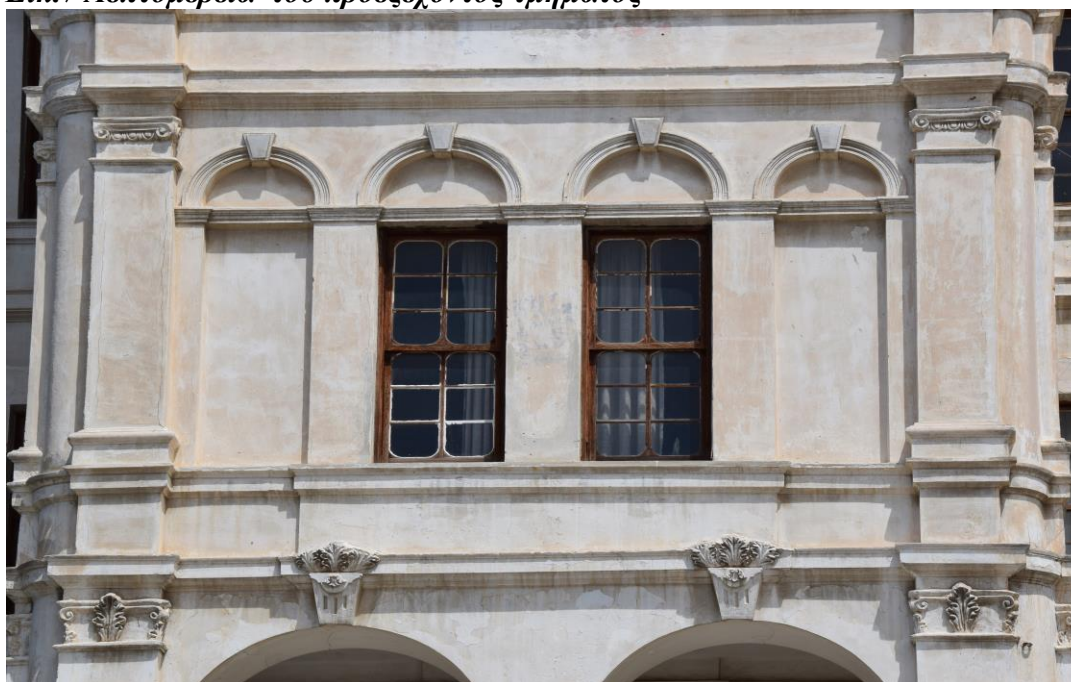
Εικ.8 Εξωτερική όψη με χαρακτηριστικό διάκοσμο
