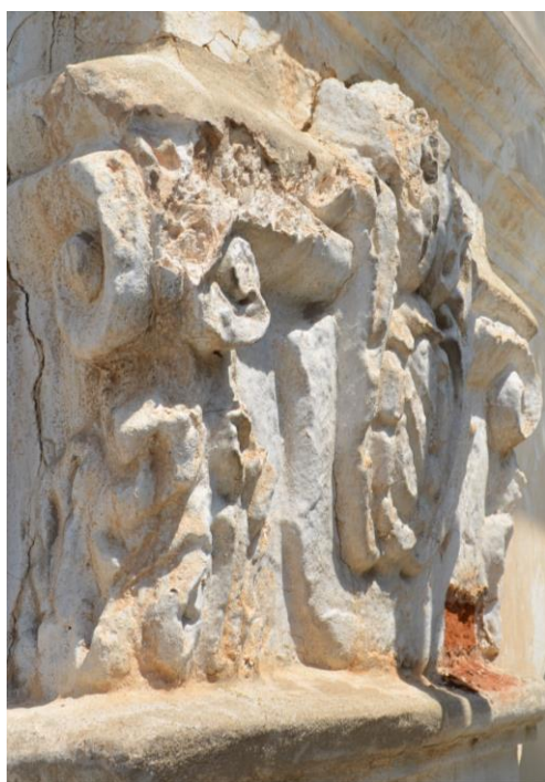
Εικ.64,65 Χωμάτινες επικαθίσεις- Απώλειες στοιχείων-Κοψελοποίηση
