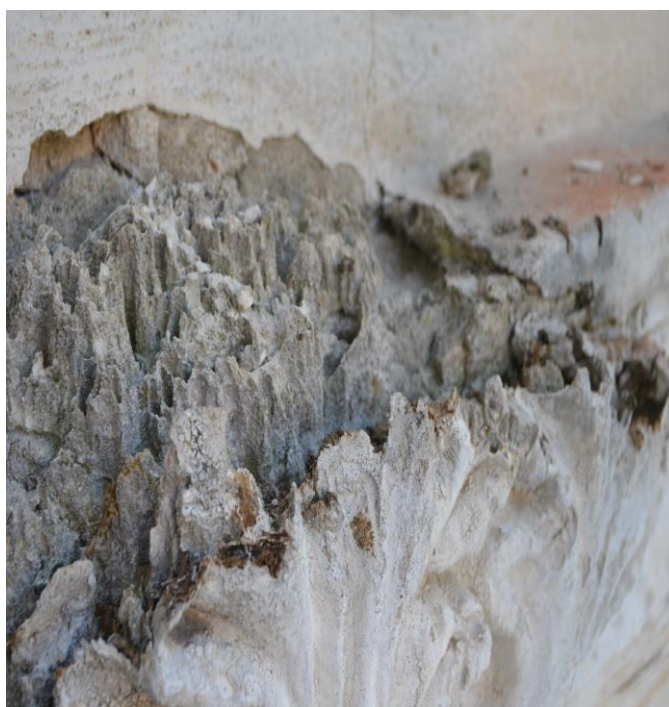
Εικ.64,65 Χωμάτινες επικαθίσεις- Απώλειες στοιχείων-Κοψελοποίηση
