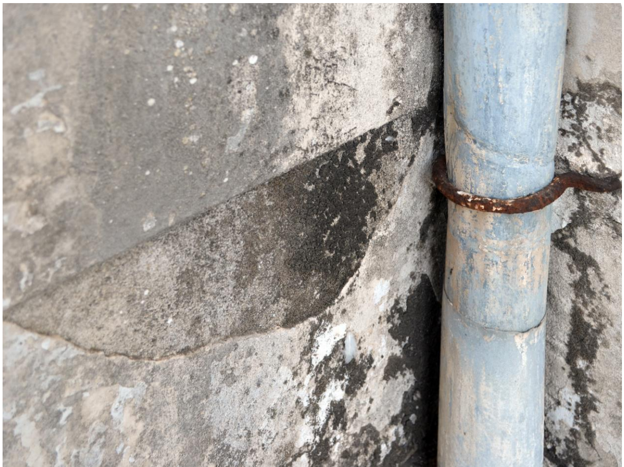
Εικ.51 Μαύρη κρούστα- Βιολογική προσβολή- Οξειδωμένο μεταλλικό στοιχείο
