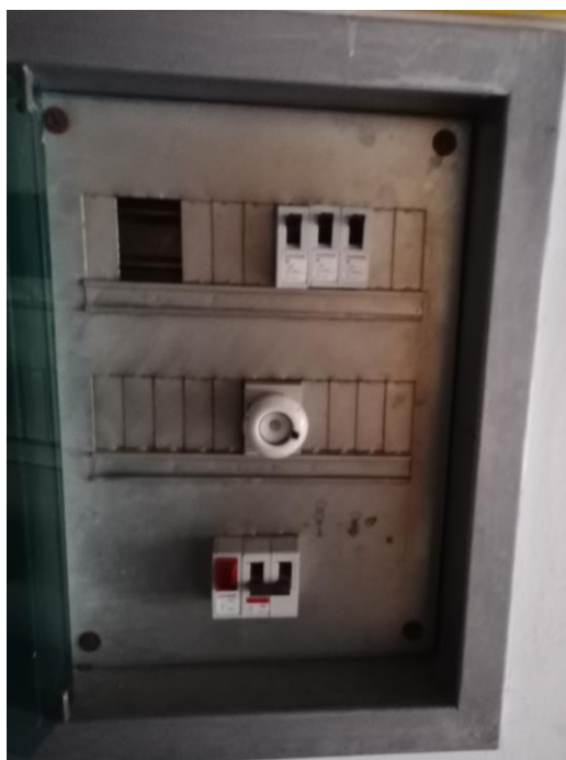
ΤΥΠΙΚΟΣ ΠΙΝΑΚΑΣ ΦΩΤΙΣΜΟΥ ΠΟΥ ΤΡΟΦΟΔΩΤΕΙΤΑΙ ΑΠΟ ΤΟ Η/Ζ
