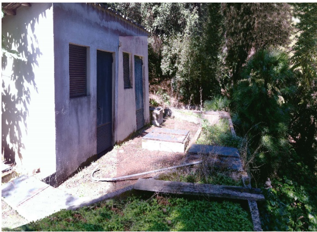
Δεξαμενές επεξεργασίας λυμάτων
