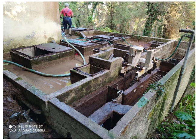
Δεξαμενές εισόδου λυμάτων
