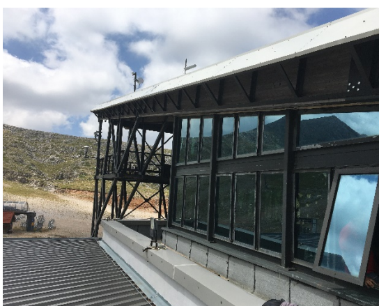
17. Απουσία πλαϊνής επικάλυψης ανατολικής όψης που αφήνει εκτεθειμένη την ακραία ξύλινη δοκό.
