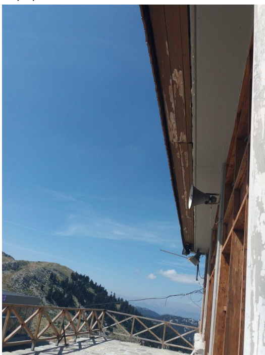
27. Τμήμα της ξύλινης επένδυσης που πρέπει να αντικατασταθεί με τραπεζοειδή λαμαρίνα
