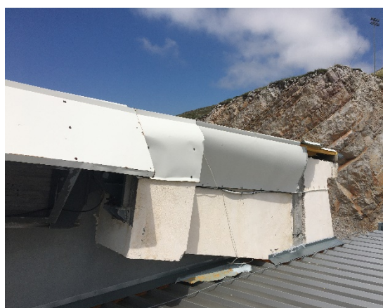
18. Πρόχειρες επισκευές επικάλυψης που πρέπει να αντικατασταθούν με σταθερά φύλλα γαλβανισμένης λαμαρίνας.
